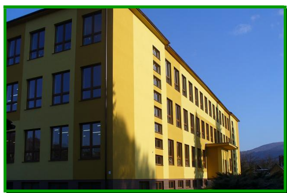
ZŠ Stakčín po rekonstrukcii
